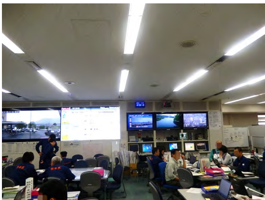
防災センター内の様子③
