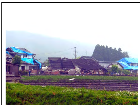
多くの家屋に被害が発生した西原村の状況②
