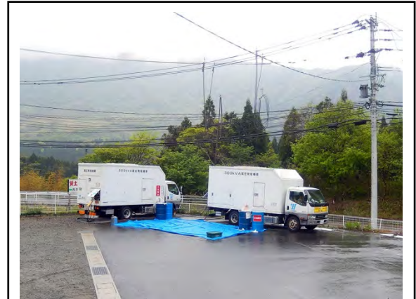
九州電力の300kVA 高圧発電機車
