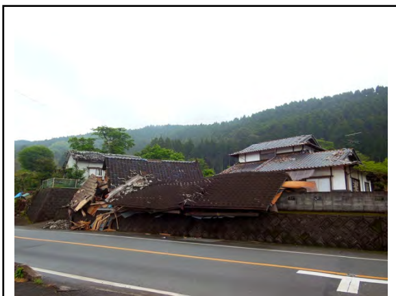
多くの家屋に被害が発生した西原村の状況①
