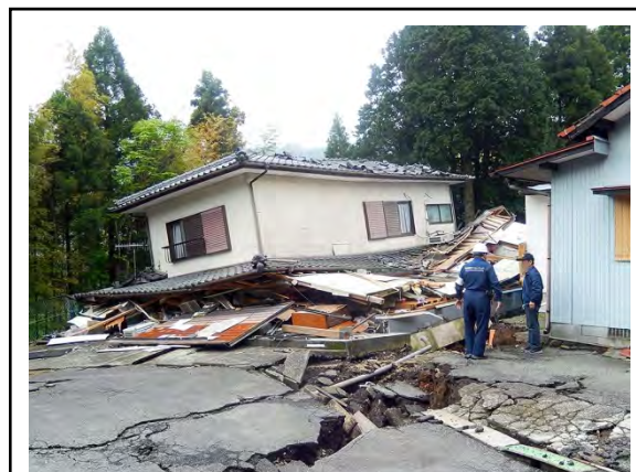
谷川に大きく崩れ、1階が完全に潰れた民宿
