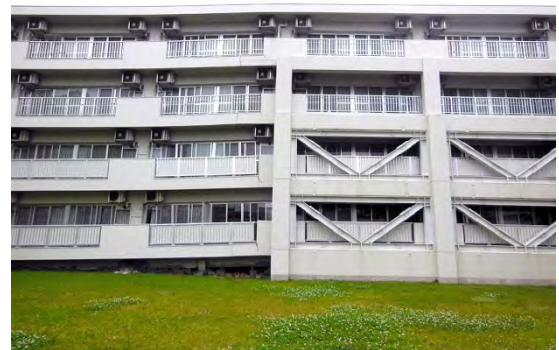
耐震補強未実施（左） 耐震補強済み（右）
