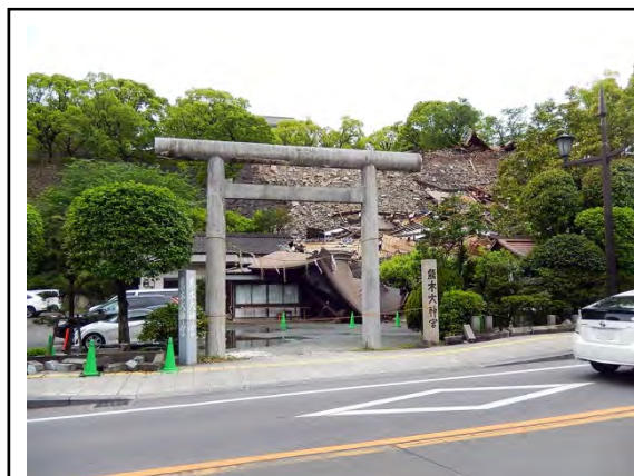
地震により倒壊した熊本大神宮
