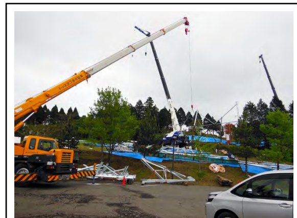
送電鉄塔の復旧工事（阿蘇大橋手前の通行止め箇所）
