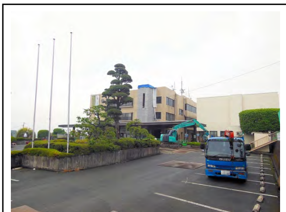
立ち入り禁止となっていた益城町役場庁舎
