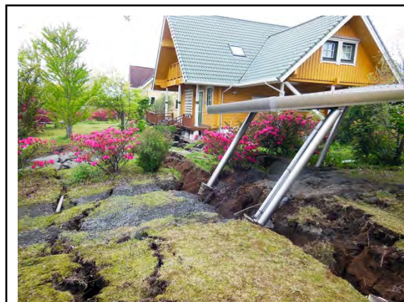
断層と思われる亀裂が住宅地を縦断する形で続く
