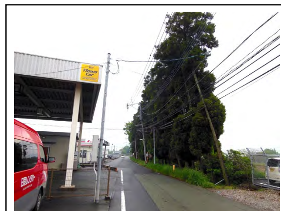
電柱とともに道路側に傾いた営業所傍の杉林
