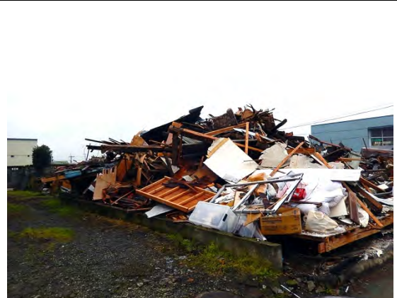
所々に積み上げられたガレキ
